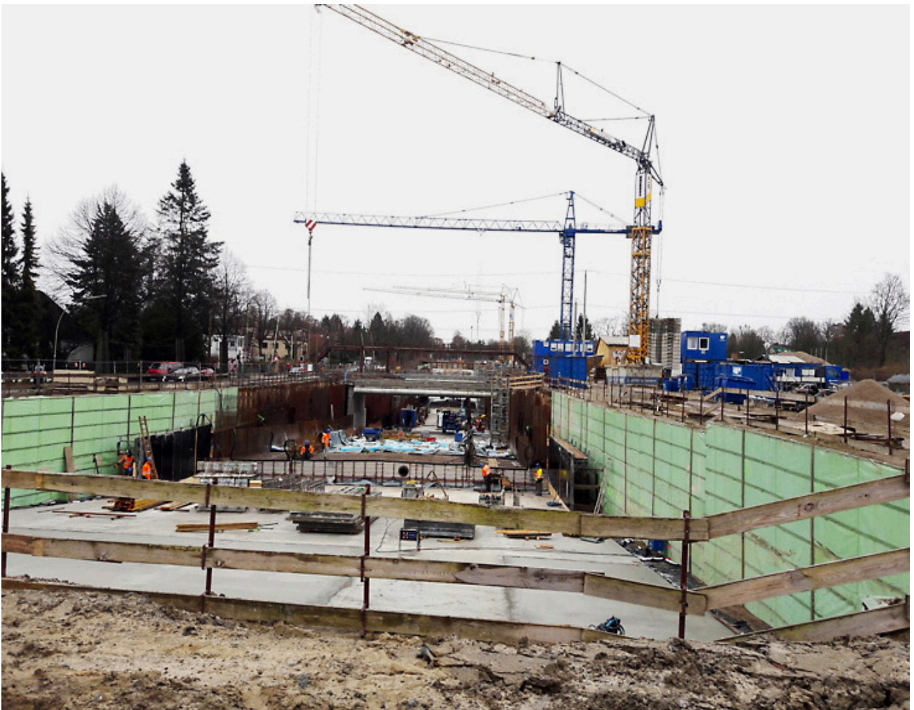
Baustelle Hammer Straße
