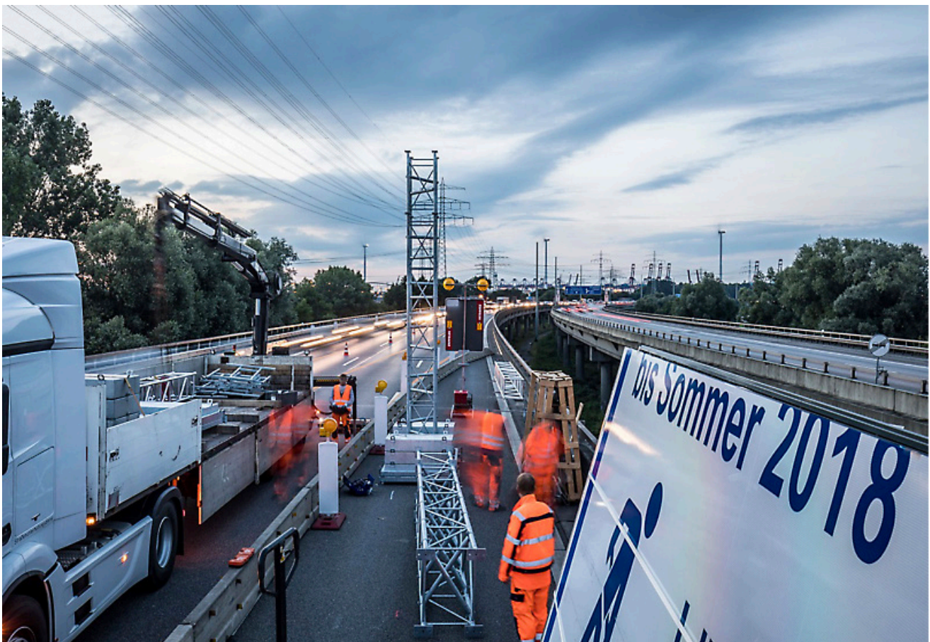
Innovative Bauvorhaben erfordern innovative Sicherungsmaßnahmen: Zum ersten Mal kam auf einer Autobahnbaustelle im Hamburger Bereich eine Verkehrsbeeinflussungsanlage zum Einsatz
