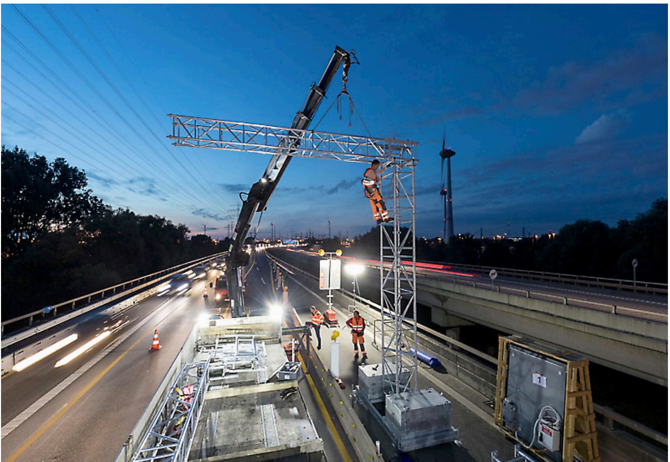
Für die Beleuchtung während der Montage sorgten Leuchtballone von Zeppelin Rental
