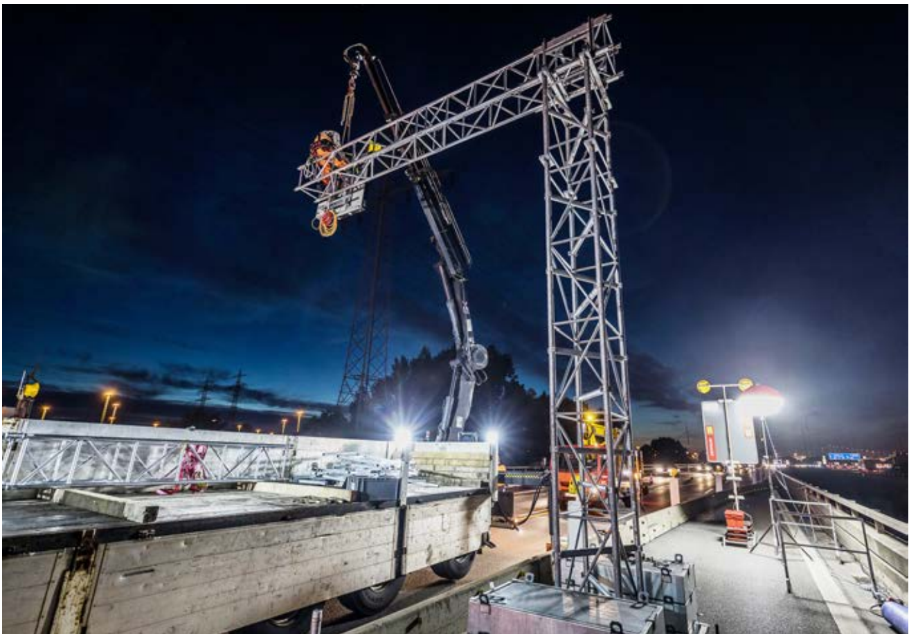
Die Kragarmkonstruktion kann auf Wunsch auch als Verkehrszeichenbrücke eingesetzt werden
