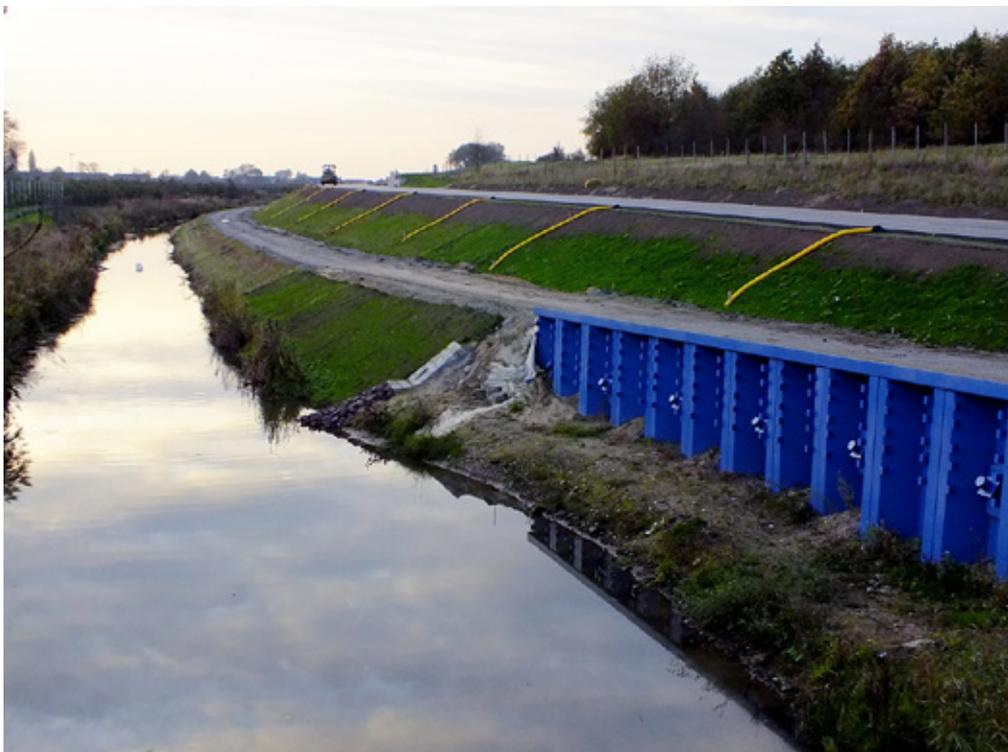
*Bild 5: Lage der Trasse am Schlickhügel (Hakengraben, Böschung, Arbeits- und Schauweg, Böschung, UFi-Fahrbahn, Schlickhügel)*
