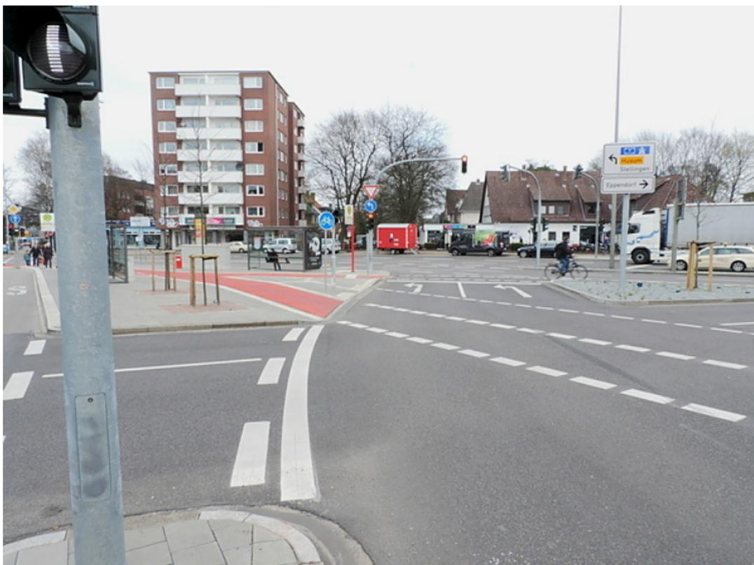
bieger aus dem südlichen Kreuzungsarm wurde ebenfalls aus der eigentlichen Kreuzung ausgelagert. Dieser Verkehr muss nunmehr erst rechts in den neu geschaffenen Teilknoten abbiegen, um dann links in seine Zielrichtung weiter zu fahren. Kurz gesagt, um links abzubiegen, muss erst rechts abgebogen werden. Diese neue Situation stellte besondere Anforderungen an die Planung. Festbeschilderung und Markierungen mussten so umgeplant werden, dass die neue Situation für alle Verkehrsteilnehmer möglichst
