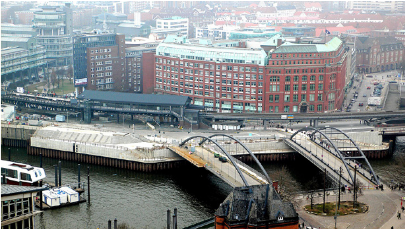
Bild 4: Die Hochwasserschutzanlage und die Niederbaumbrücken
