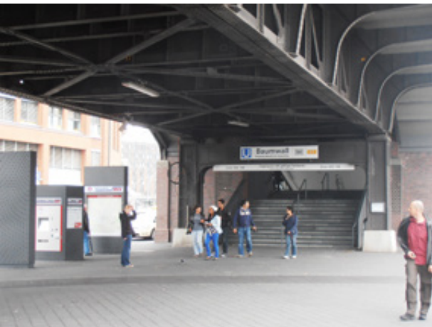
Bild 3: Der neue U-Bahn-Ausgang
